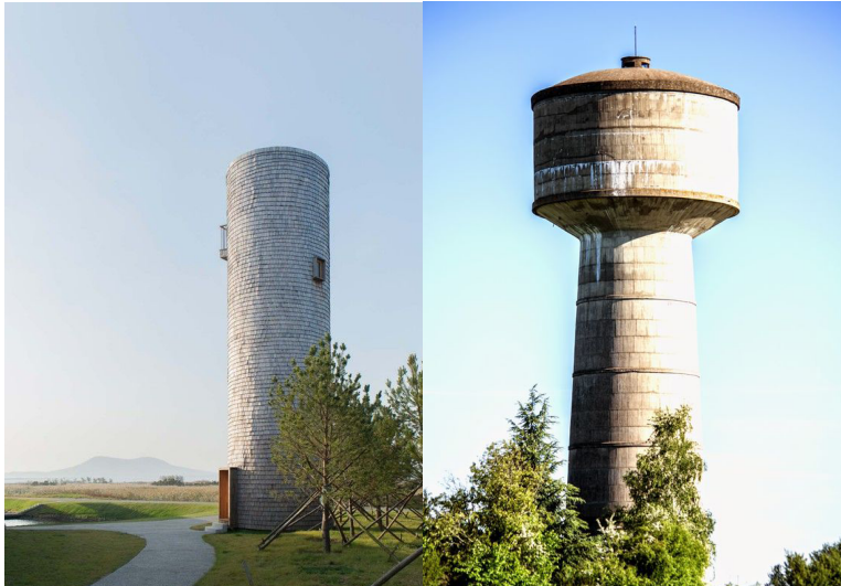
CHATEAU D'EAU, EN FORME DE TOUR
